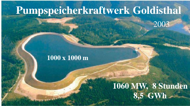
Abbildung 9.12 Pumpspeicherkraftwerk Goldisthal. Quelle: Vattenfall Europe
