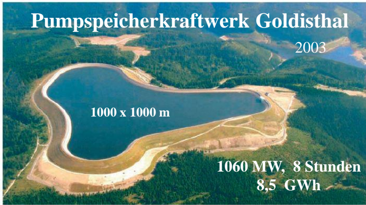
Abbildung 9.12 Pumpspeicherkraftwerk Goldisthal. Quelle: Vattenfall Europe
