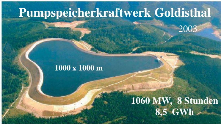
Abbildung 9.12 Pumpspeicherkraftwerk Goldisthal. Quelle: Vattenfall Europe
