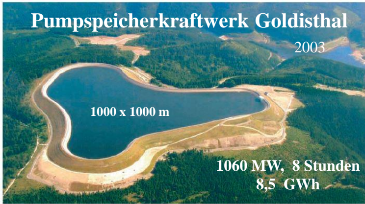
Abbildung 9.12 Pumpspeicherkraftwerk Goldisthal. Quelle: Vattenfall Europe
